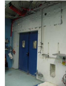
Renforcement d'un linteau ©CEA
