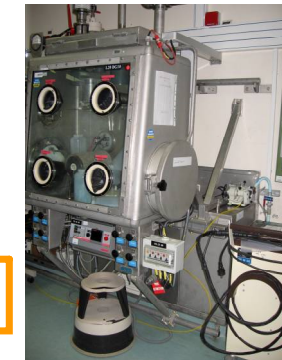
Ancrage de boîte à gants ©CEA
